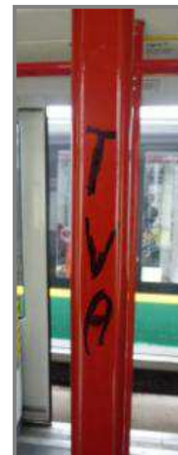
Non Conforme en exploitation
